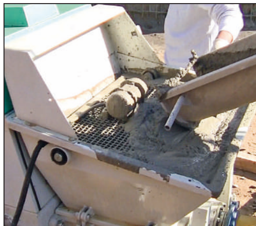
Alimentada con camión hormigonera, autohormigonera o planta de hormigón.
