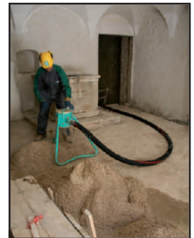
Caballete/trípode para recepción y reparto de los morteros y áridos en planta. Se suministra siempre de serie
