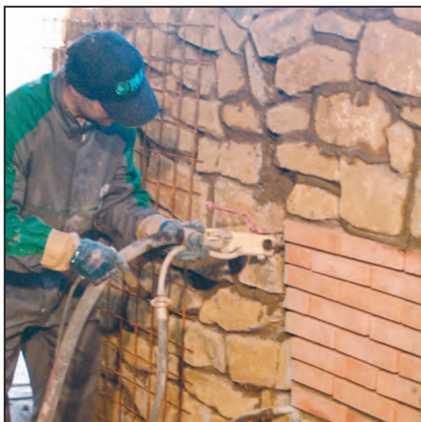
Realizar relleno de juntas
