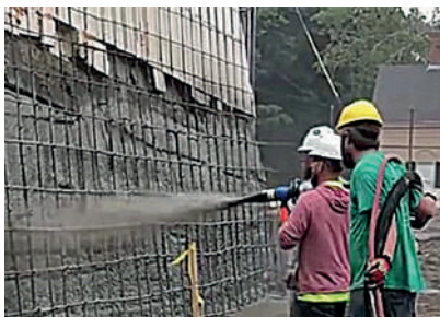
Para gunitar con kit bomba tipo 60.12 y con proyector para gunitado.
