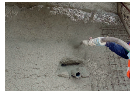
Para enfoscar morteros tradicionales premezclados y monocapas.
