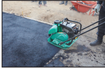
Con depósito de agua para la compactación del asfalto
