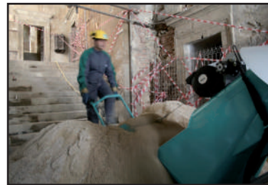
Esgráper/mulilla "opcional", de tracción hidráulica, para facilitar la carga de los materiales sobre la tolva/skip, reduciéndose el esfuerzo personal, y agilizándose el ciclo de trabajo
